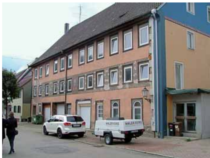
Das Vordergebäude der Werkstätte, in der zunächst Michael Welte und später Imhof & Mukle ihre Instrumente bauten, ist auch heute noch vorhanden. Foto: Bernhard Häberle
