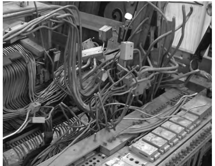
Ein Teil der Verrohrung während der Demontage
