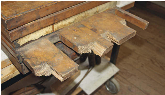
Beim groben Ausbau ausgebrochene Balglager
