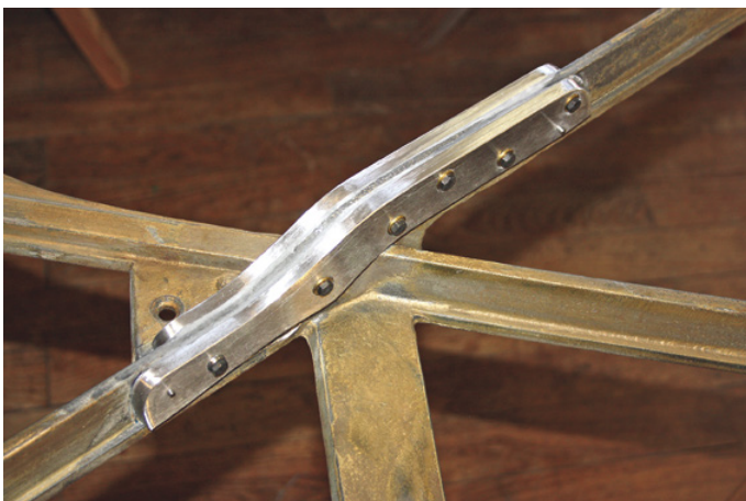
Kraftschlüssiges Verbinden und Verschrauben der Risse mit gefrästen und geschmiedeten Stahl-Streben
