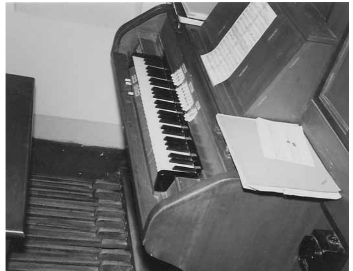
Historische Aufnahme des Lonsheimer Voit-Spieltischs mit dem Kasten des Spielapparats, der in geschlossenem Zustand als Notenpult diente. Links unter der Manualklaviatur die zwei Tasten für den Vor- und Rücklauf der Notenrolle, sowie der Tempo-Hebel. Der erste Registerschalter links über der Klaviatur war die Basskoppel. Foto: Walter Schmidt
